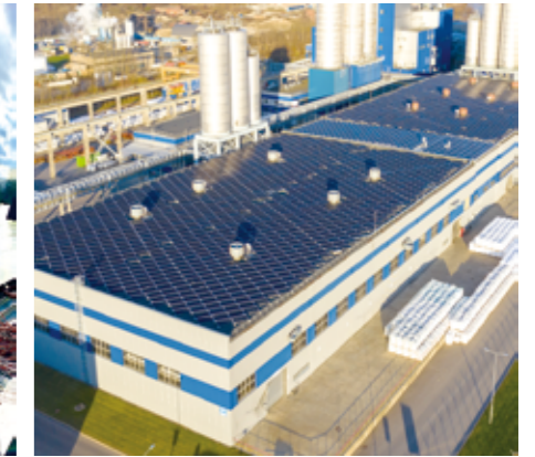
設置場所: リトアニア 設置容量: 1MW
