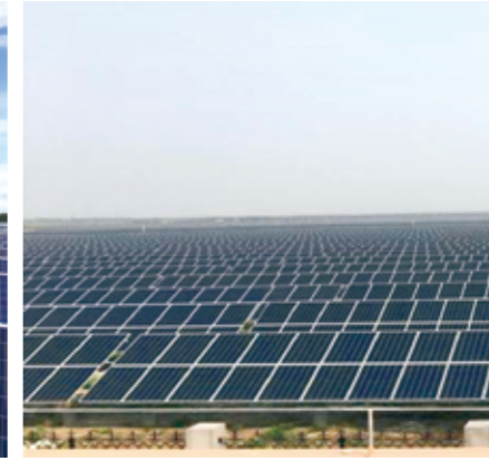
設置場所: 中国唐山 設置容量: 20MW
