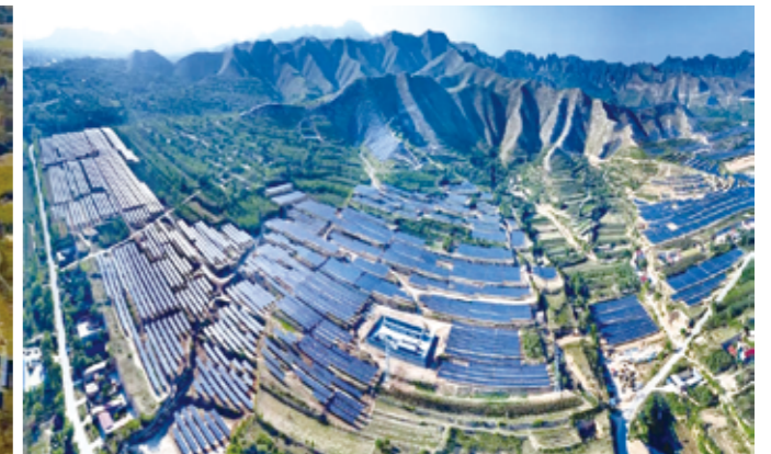
設置場所: 中国山西省 設置容量: 130MW
