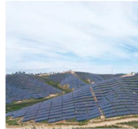
設置場所: 中国河北省石家莊 設置容量: 30MW
