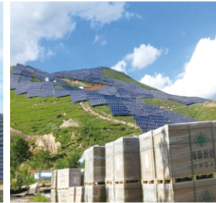
設置場所: 中国河北省保定市 設置容量: 20MW
